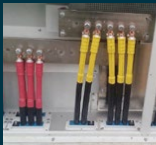
1. Cajas de combinador/ inversores monofásicos
