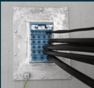
5. Edificios de control
